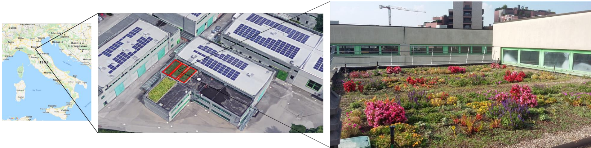
Figura 2. Área experimental do telhado verde ornamental, no departamento DICAM ( 44^{\circ}30'49.1'' N, 11^{\circ}19'06.3'' E) do Campus de Engenharia da Universidade de Bolonha (UNIBO) aos 127 DAP. Bolonha (BO), Itália, 2018. Fotos: Google maps, 2019; SILVA, S. Á., C. G. (2019).
